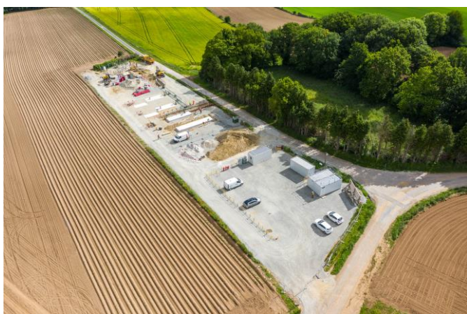
La station de rebours en cours de travaux – Mai 2019.
